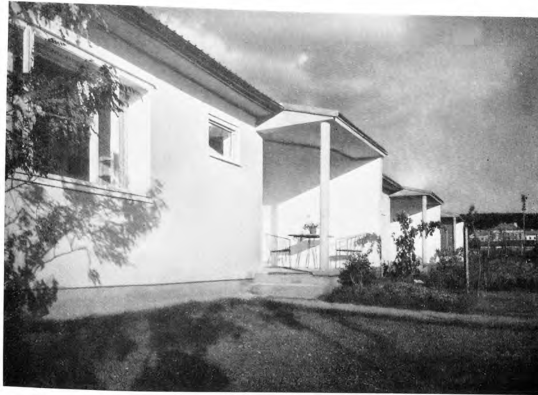
Bild 18. Blick in die überdeckten Sitzplätze der Type B. Im Hintergrund das Schloß Mannersdorf. Die Sitzplätze sind durch seitliche Mauern gegen die Nachbarhäuser geschützt. Gesimse und Säulen schalreiner Beton. Mit Ausnahme der Verbundkippflügel der Flure gehen die Fenster nach außen auf, die großen Mittelscheiben der Wohnzimmerfenster sind außen fest verglast.
