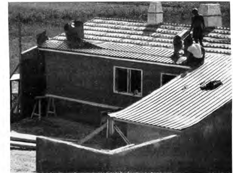
Bild 10. Eindecken des Massivdaches mit auf Ziegellatten verlegtem „Fural“.
